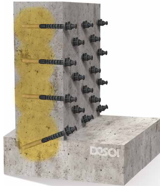
Flächeninjektion | Masonry injection
